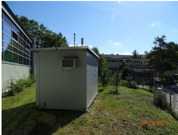
Abb. 1: DETH041 Jena Dammstr.
